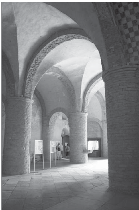
Figs. 80, 81 y 82. Arriba izquierda. CATEDRAL DE SANTIAGO DE COMPOSTELA (siglo XI). Tribuna sur de la nave central. Bóvedas de cuarto de cañón sobre arcos diafragma en función de fajones correspondientes con los de la nave central. A la izquierda se abren las ventanas de la tribuna. Arriba derecha. SAINT PHILIBERT DE TOURNUS (Francia, siglo XI-XII). Capilla de San Miguel en el interior del piso superior del cuerpo occidental lombardo del siglo XI. Vista hacia la cabecera de la iglesia. Las naves laterales se cubren con bóvedas de cuarto de cañón. El pequeño ábside situado hacia la nave está hoy cegado por un órgano. Ver los tirantes de madera de la bóveda alta que aún nos llegan. Abajo. Atrio del cuerpo occidental lombardo, vista desde el noreste con la nave central y la lateral sur. Ver cómo las bóvedas de medio cañón transversal estriban las de arista de la nave central.
