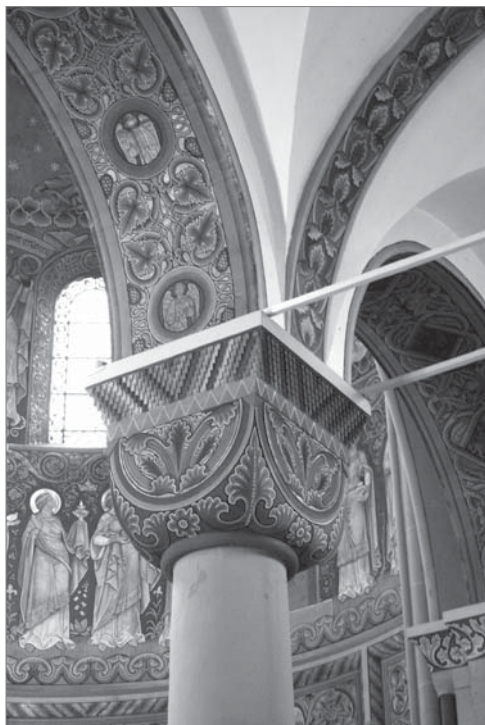
Figs. 249, 250 y 251. Arriba. SAN GOTARDO (Hildesheim, Alemania, siglo XII). Salmeres compartidos. Abajo izquierda. SAINT PHILIBERT DE TOURNUS (Francia, siglos XI-XII). Salmeres independientes de arcos y bóveda de arista, en su atrio del cuerpo occidental lombardo. Abajo derecha. LA CHARITÉ SUR LOIRE (Francia, siglos XI-XII). Ver cómo el ábaco del capitel correspondiente a una columna del deambulatorio, se prolonga para recibir el arco fajón de una bóveda de un tramo del mismo y que los salmeres sean independientes.
