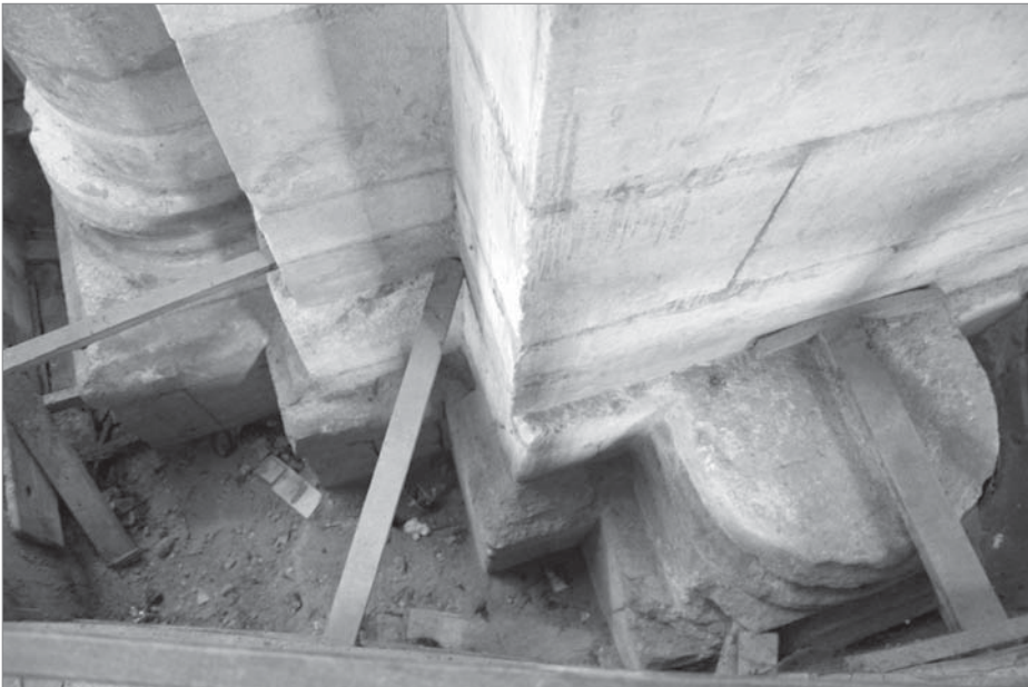
Figs. 27 y 28. Arriba. SAN MIGUEL DE CUXÁ (Rosellón, Francia, siglo XI). Pilar sur de la nave central, se ve cómo apoya en un dado emergente de fábrica de mampostería. Abajo. LA CHARITÉ SUR LOIRE (Francia, siglo XI). Vista de las subestructuras de cimentación de un pilar compuesto de su nave central. Los puntalitos de madera que se pueden ver, en función de sujeción de los tablonces de contención de la tierra del entorno de la zanja abierta, se partirán fácilmente si estas empujan.
