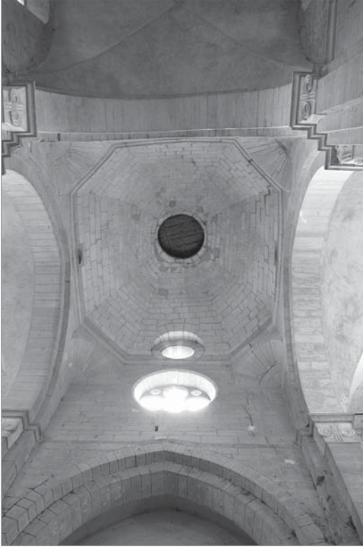
Figs. 131, 132 y 133. Arriba izquierda. SAINT PHILIBERT DE DIJÓN (Francia, siglo XI-XII). Cúpula de gajos sobre trompas, correspondiente a una planta sensiblemente rectangular. Ver la desigualdad de los gajos en función de los lados de la planta Arriba derecha. Croquis con el plano de base del casquete deformado. Abajo. SAN MARTÍN DE FRÓMISTA (España, siglo XI). Ver el notable cimborrio.
