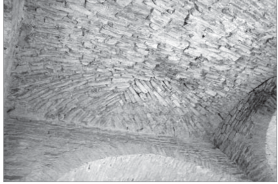
Figs. 83, 84 y 85. Arriba izquierda. SANT PHILIBERT DE TOURNUS (Francia, siglo XI-XII). Bóvedas de la nave central de la iglesia, de eje transversal a la nave. Arriba derecha. Capilla de San Miguel. Detalle de los «arcos concéntricos» de la plementería de una bóveda de cuarto de esfera de un tramo de la nave lateral norte, hacia la nave central. Abajo. ABACIAL CISTERCIENSE DE FONTENAY (Francia, siglo XII). Vista hacia los pies de la iglesia. Ver las bóvedas de medio cañón transversales al eje de la nave central, con el autor de este texto más joven.
