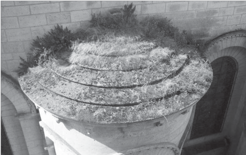
Figs. 192, 193 y 194. Arriba. TEJAS ROMÁNICAS. MUSEO DE SAINT BENIGNE DE DIJÓN (Francia). Ver las piezas inferiores iguales que las tegulae romanas y la teja ya de tipología «árabe» que cubre la junta y sustituye al imbrex romano. Centro. TEJAS ROMANAS CON TEGULAE E IMBEX . Museo Provincial de Zaragoza. Abajo. CATEDRAL DE ANGOULÊME (Francia, siglo XII): Losas de piedra sobre un absidiolo.
