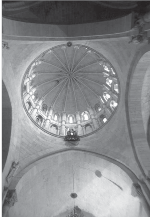
Figs. 143 y 144. Arriba. MONASTERIO DE FONTEVRAUD (Francia, siglos XI-XII). Vista de la chimenea central, formada por ocho gajos rectos sobre trompas en la que a su vez se abren otras cuatro chimeneas. Ver las que se abren tras los arcos torales. Abajo. CATEDRAL DE SALAMANCA (España, siglo XII). Cúpula de casquete ya gótico, con gajos sobre arcos meridianos y sobre un tambor románico con un magnífico clerestorio doble y pechinas de transición.
