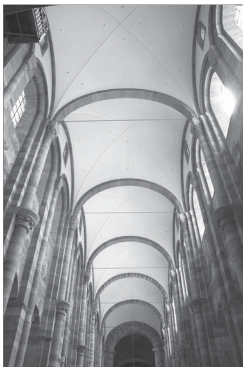
Figs. 86 y 87. Arriba. CATEDRAL DE PARMA (Italia, hacia 1162). Tirantes en la nave lateral norte. Abajo. CATEDRAL DE SPEYER (Renania, Alemania, siglo XI). Tirantes en las bóvedas de arista de su nave central.
