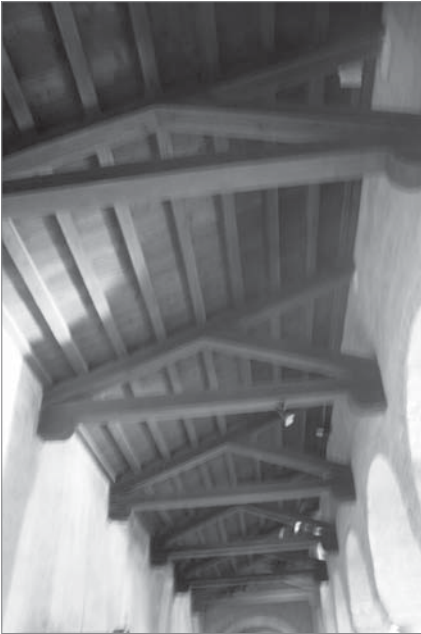
Figs. 186, 187 y 188. Arriba. ABACIAL DE SAN SILVESTRE DE NONANTOLA (Módena, Italia, siglo XII). Armaduras reconstruidas en el siglo XVIII en la nave lateral sur. Abajo izquierda. SEMICERCHAS SOBRE LA NAVE LATERAL NORTE DE SAN PIETRO IN AGLIATE (Milán, siglo XI). Abajo derecha. SAN CLEMENTE DE TAHULL (Lérida, España, siglo XII). Pares reconstruidos.
