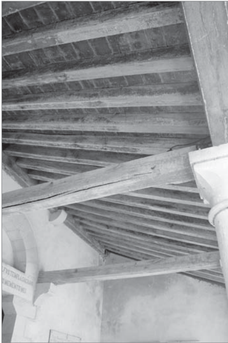
Figs. 183, 184 y 185. Arriba. SAN MIGUEL, CATEDRAL DE LA SEO DE URGEL (Lérida, España, siglos XI-XII). Cubierta sobre arcos diafragma apuntados de su nave, reconstruida. Ver cómo la tablazón se apoya sobre los pares y estos en las correas. En este caso las correas se reciben en mensulitas ligeramente voladas que colaboran a acortar su luz. Abajo izquierda. GERMIGNY DES PRÉS (Loire, Francia, para las armaduras mediados del XI). Armaduras sobre la nave lateral sur. Abajo derecha. CROQUIS Sobre lo explicado por Frédéric Épaud sobre estas armaduras referenciadas en el texto.
