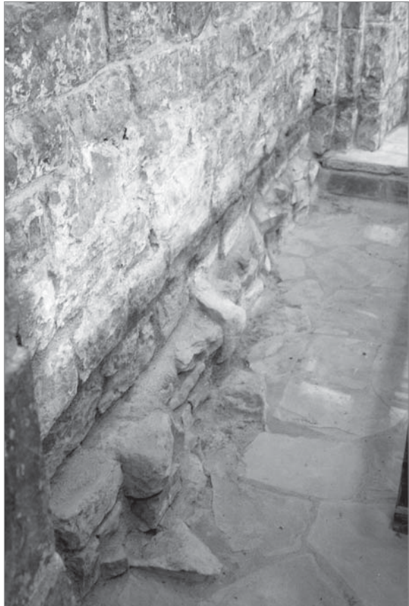
Figs. 17 y 18. Arriba. SAN ETIÉNNE DE NEVERS (Francia, siglo XII). Ver el notable zócalo-banqueta emergente en los muros de sus ábsides. Abajo. ABACIAL DE NTRA. SRA. DE OBARRA (Huesca, primer tercio del siglo XI, románico-lombarda). Ver en el interior del muro norte del séptimo tramo, cómo emerge un zócalo de fábrica de mampostería en función de banqueta de fundación.
