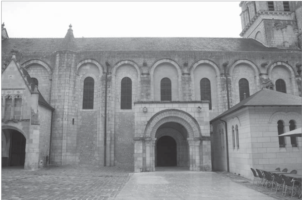
Figs. 31 y 32. Arriba. CATEDRAL DE LÉRIDA (siglo XII). Vista parcial del paramento exterior del muro sur. Ver los sillares muy afectados por la degradación y las delgadas juntas dispuestas entre ellos. Abajo. NOTRE DAME LA GRANDE (Poitiers, Francia, siglo XI-XII). Ver los contrafuertes exteriores del muro sur enlazados superiormente por arcos.
