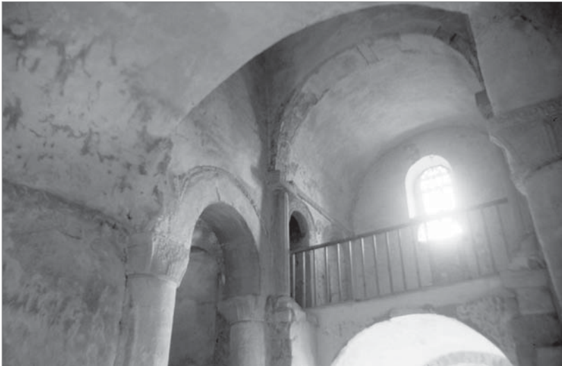
Figs. 263, 264 y 265. Arriba izquierda. SANTA MARÍA DEL NARANCO (Oviedo, España, hacia 848). Interior de la noble planta alta, con su bóveda de medio cañón sobre arcos fajones apilastrados en semicolumnas que se corresponden perfectamente con los contrafuertes exteriores. Arriba derecha. Ver los contrafuertes exteriores y la magnífica tribuna. Abajo. SAN MIGUEL DE LILLO (Oviedo, España, 842-850). Vista de la tribuna sobre el atrio, desde la nave.
