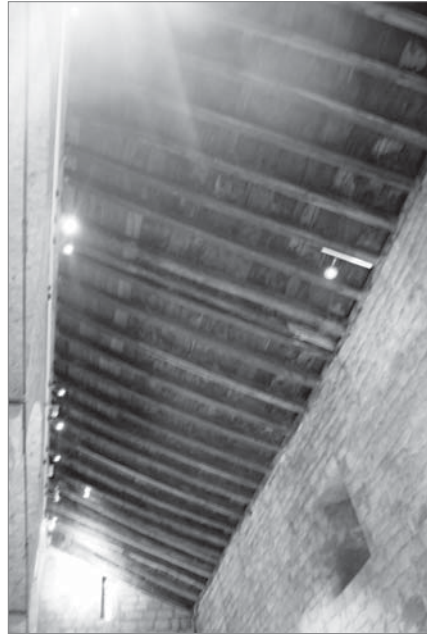
Figs. 186, 187 y 188. Arriba. ABACIAL DE SAN SILVESTRE DE NONANTOLA (Módena, Italia, siglo XII). Armaduras reconstruidas en el siglo XVIII en la nave lateral sur. Abajo izquierda. SEMICERCHAS SOBRE LA NAVE LATERAL NORTE DE SAN PIETRO IN AGLIATE (Milán, siglo XI). Abajo derecha. SAN CLEMENTE DE TAHULL (Lérida, España, siglo XII). Pares reconstruidos.
