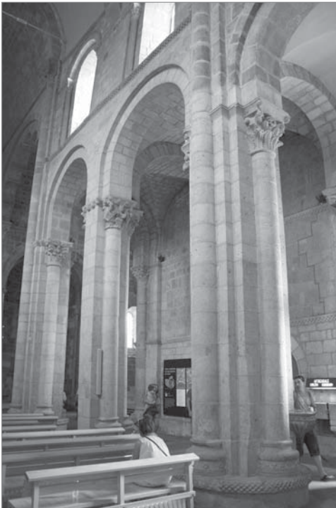
Figs. 214, 215 y 216. Arriba izquierda. CATEDRAL DE SANTIAGO DE COMPOSTELA (siglo XI). Nave central hacia la cabecera, lado sur. Ver los pilares cruciformes de núcleo circular el de primer plano y de núcleo cuadrado el siguiente, con semicolumnas en sus cuatro caras. SAN ISIDORO DE LEÓN (siglo XI). Arriba derecha. Nave lateral sur. Pilares de núcleo cruciforme con semicolumnas en sus cuatro caras, y la semicolumna del muro exterior. Abajo. Pilares de núcleo cruciforme con semicolumnas en sus cuatro caras y pilares alternados cruciformes de núcleo cuadrado y semicolumnas sólo en las caras de los arcos que separan las naves, conformando «tramos dobles».
