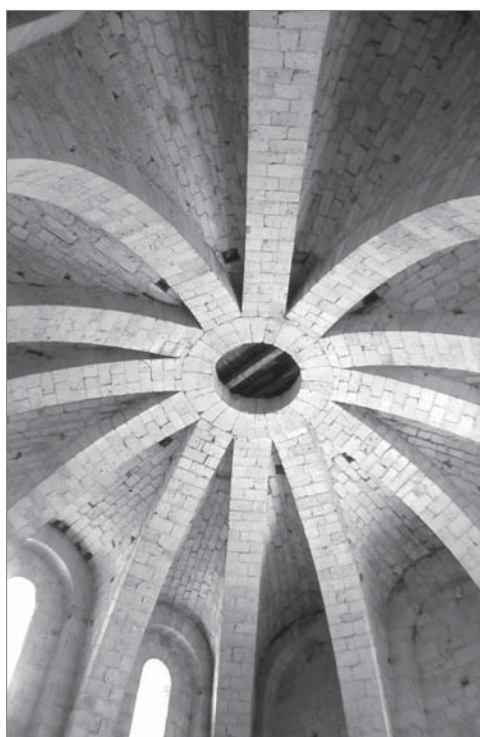
Figs. 293 y 294. Arriba. CATEDRAL DE MAINZ (Renania, Alemania, siglos XII-XIII). Entrega de los arcos diagonales y fajón de dos bóvedas de crucería cuatripartita en la semicolumna apilastrada del arco fajón. Abajo. MOISSAC. TORRE OCCIDENTAL (Francia, 1130). Cuerpo superior. Cúpula de crucería sobre arcos diagonales de sección rectangular.
