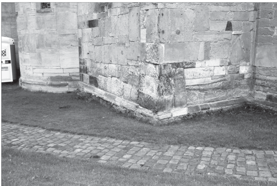
Figs. 19 y 20. Arriba. ABACIAL DE NTRA. SRA. DE OBARRA (Huesca, primer tercio del siglo XI, románico-lombardo). Ver el macizo de mampostería emergente en que se entrega el pilar de triple articulación. Probablemente como consecuencia de alguna modificación en los niveles del pavimento. Abajo. SAN MIGUEL DE HILDESHEIM (Alemania, inicios del siglo XI). Ver el zócalo de transición al cimiento en la base de su cabecera.
