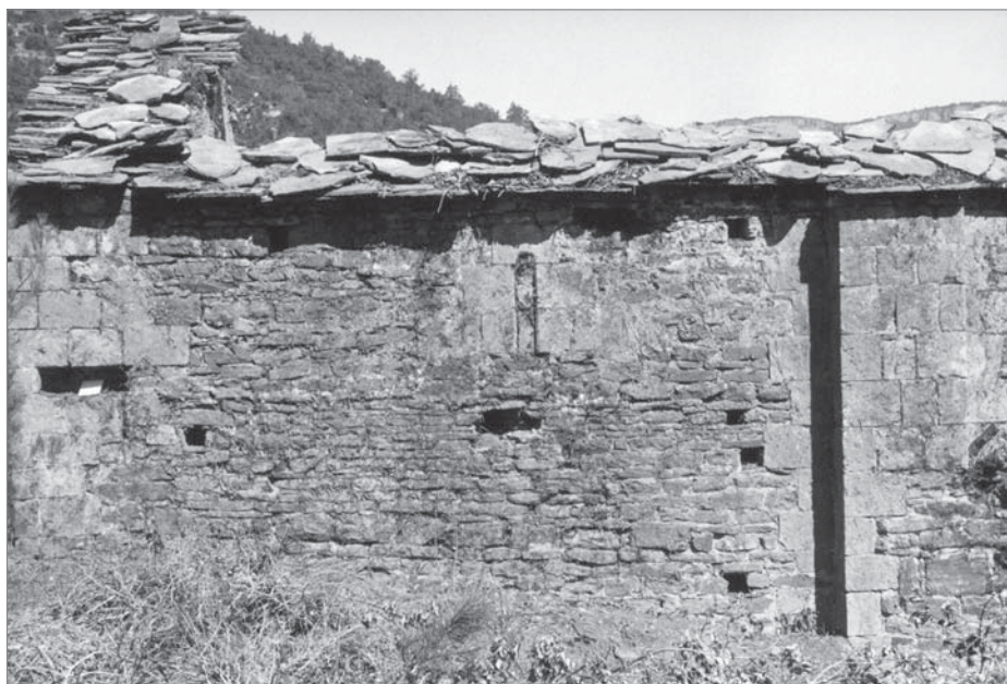
Figs. 29 y 30. Arriba. SAINT PHILIBERT DE TOURNUS (siglo XI. Francia). Fragmento de aparejo de opus spicatum en el paramento del un absidiolo de cabecera recta. Abajo. SAN JACOBO DE RUESTA (siglo XI. Huesca). Paramento del muro sur de mampostería románica. Con recercado de piezas de piedra de mayor tamaño en ventanas y extremos del muro. Antes de la restauración que dirigió.
