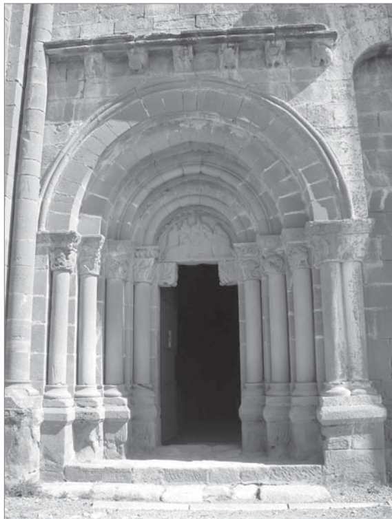
Figs. 42, 43 y 44. Arriba. SANTIAGO DE AGÜERO (Huesca, siglo XII). Puerta sur. Ver las arquivoltas que se articulan con columnitas alojadas en los retranqueos de las jambas. Abajo izquierda. SAN VICENTE DE ÁVILA (España, siglos XI-XII). Puerta occidental. Tímpano doblemente articulado y columna central configurando dos vanos de acceso. Abajo derecha. NOTRE DAME LA GRANDE (Poitiers, Francia, siglo XII). Portada occidental.
