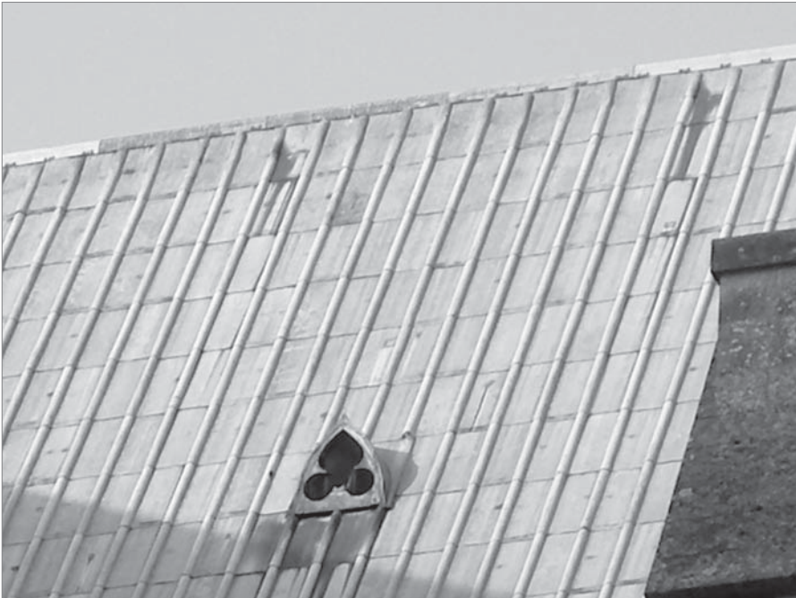
Figs. 198 y 199. Arriba. CENOTAFIO DE LOS SANTOS NIÑOS VICENTE, SABINA Y CRISTETA (San Vicente, Ávila, España, siglo XII). Ver las tejas de castañuela talladas en la cubierta inferior del cenotafio, que se repiten en la que cubre el conjunto. Abajo. CATEDRAL DE CHARTRES. Ver el faldón norte de la cubierta actual de piezas de plomo, siglo XIX, que refleja bien con las variaciones naturales, cómo pudieron ser las cubiertas de plomo medievales.
