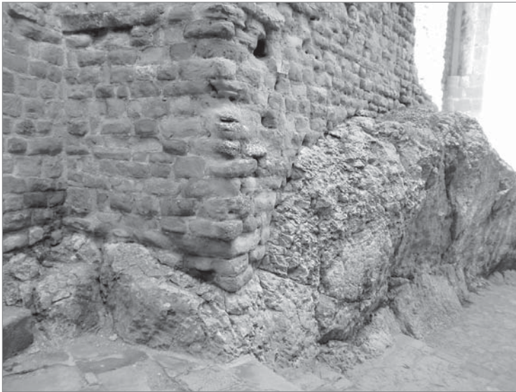
Figs. 21, 22 y 23. Arriba izquierda. CASTILLO DE LOARRE (Huesca, siglos XI-XII). Iglesia románico-lombarda del primer recinto (primer tercio del siglo XI). Ver cómo el muro oeste se apoya directamente en la roca emergente mediante un breve zócalo o banqueta de cimentación. Arriba derecha. QUINTANILLA DE LAS VIÑAS (Burgos, siglo VII). Iglesia hispano-visigoda. Planta de su estado actual, reflejando el sistema en retícula de cimentación de su nave perdida, con sus cimientos entre los pilares de la planta central y los muros. Abajo. CASTILLO DE LOARRE (Huesca, siglos XI-XII). Muro exterior del primer recinto románico-lombardo (primer tercio del siglo XI). Ver cómo se adaptan directamente los sillarejos a la naturaleza de la roca.
