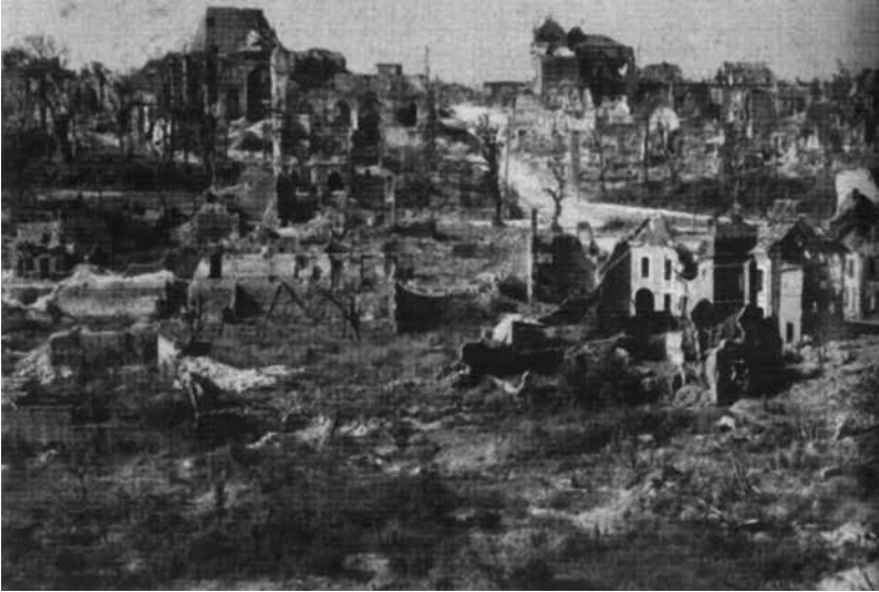
Lámina 38. El coste de la reconstrucción: las ruinas de Montdidier (Somme), junio de 1919. Foto: Collection Albert Kahn.
