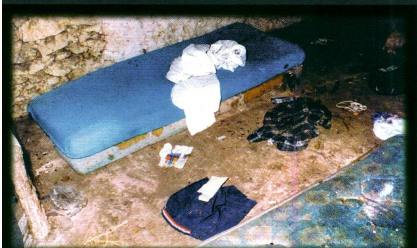
FOTOGRAFIA NUM. -12 Vista parcial del ángulo derecho de la buhardilla tomando como referencia la subida de la escalera, donde se aprecian colchones y diversas ropas y objetos.
