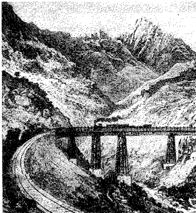
Viaducto de Los Maquis en el ferrocarril de Santiago a Valparaíso. Cuesta del Tabón.
