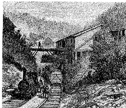
Entrada a una mina de carbón en Coronel.
