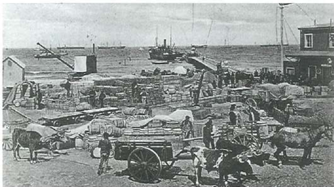
Actividad en el muelle de carga de Punta Arenas.
