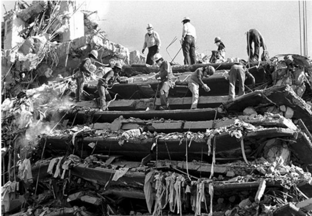
Edificio en la ciudad de México derruido por el terremoto de 1985.
