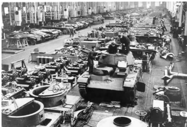
Fabrica de tanques alemana. 1939.
